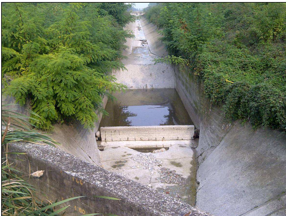
Figura 9 – Vasca di dissipazione esistente a valle del salto ove a monte è prevista la realizzazione dell'opera di presa dal CSNO
